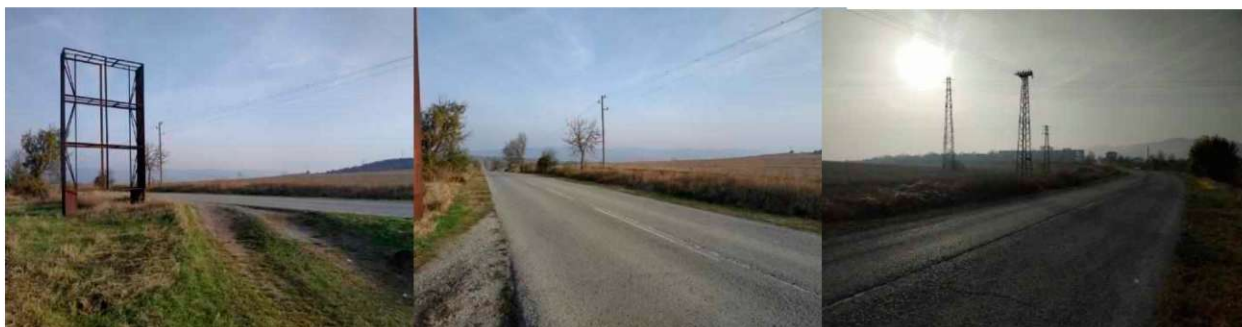
Изглед на трасето от новопоставено ЖР в ПИ 58222.57.18 в линията на Електропровод - „Кочово“ 20 кв.
